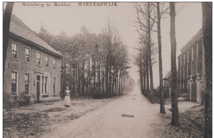
Original: Stenkamp Fast alle Fahrbahnen der Chausseen bestanden noch bis zum Anfang des 20. Jahrhunderts aus einer festgewalzten Kiesdecke. Die immer wieder neu ausgelegten Holzklötze sorgten für eine gleichmäßige Befahrung aller Bereiche, wie dieses Foto aus Winterswijk, NL, zeigt.
