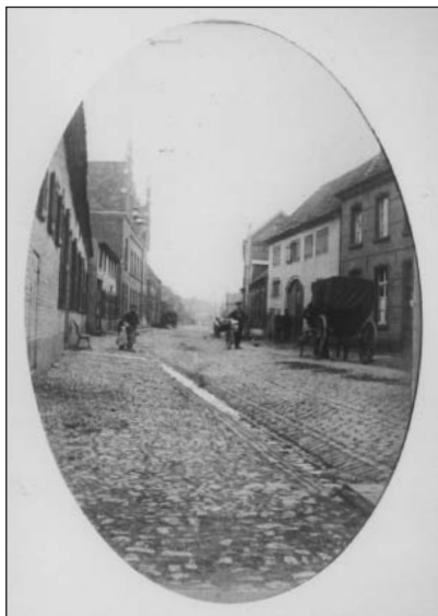
Fotosammlung Siemen, Ringenberg Nur die kurzen Ortsdurchfahrten der Dörfer besaßen eine gepflasterte Fahrbahn mit Wölbung und Abzugsrinnen. Das Pflaster in Ringenberg wurde 1903 aus Grauwacke neu verlegt, weil das alte zu glatt geworden war.
