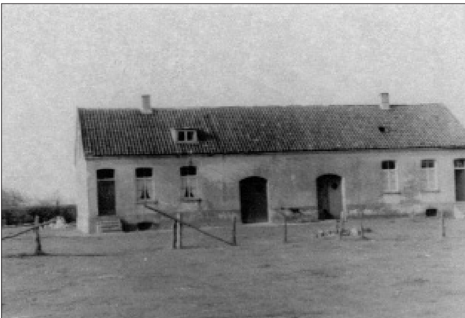
Fotosammlung: Anneliese Otto Das Tagelöhnerhaus gehörte zum Gutshaus Bergfrede und wurde von den Tagelöhnern Kohlenbrenner und Hardacker bewohnt. Seit 1958 wird es nach umfangreichen Umbau- und Renovierungsarbeiten von der Familie Beuting bewohnt. (Bergfrede Haus-Nr. 32 und 34)
