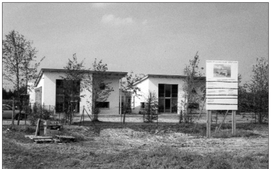
Foto: Heinz Breuer Der Katholische Kindergarten "Arche Noah" kurz vor der Fertigstellung im August 2000.
