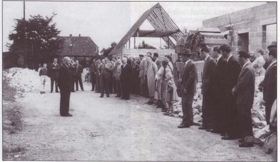
Anlässlich des Richtfestes im Mai 1957 sprach Herr Kier von der Familienhilfe Essen zu der „Siedlergemeinschaft Gartenstraße“. Auf der rechten Seite vorne die Baustelle von Heinz und Anni Hengstermann, dahinter das gerichtete Haus von Anton, jetzt Michael Koch. Im Hintergrund das alte Wohnhaus der Familie Weßling.
