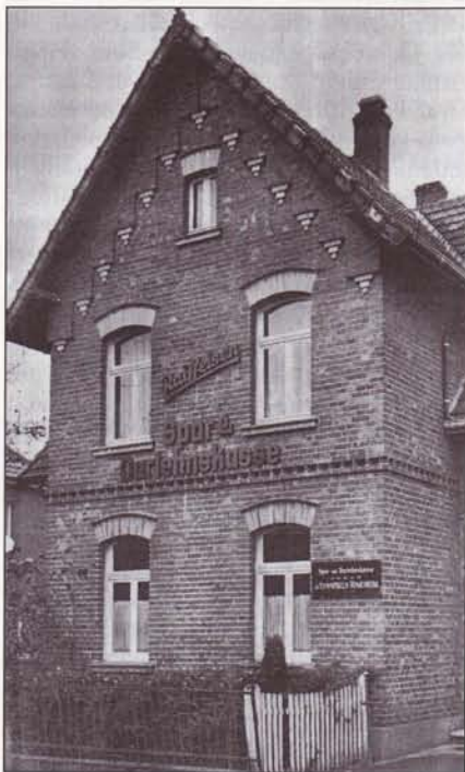
Das erste eigene Geschäftshaus der ehem. Spar- und Darlehnskasse Hamminkeln-Ringenberg auf der Molkereistraße Hamminkeln Nr. 33, heute Molkereistraße 8.
