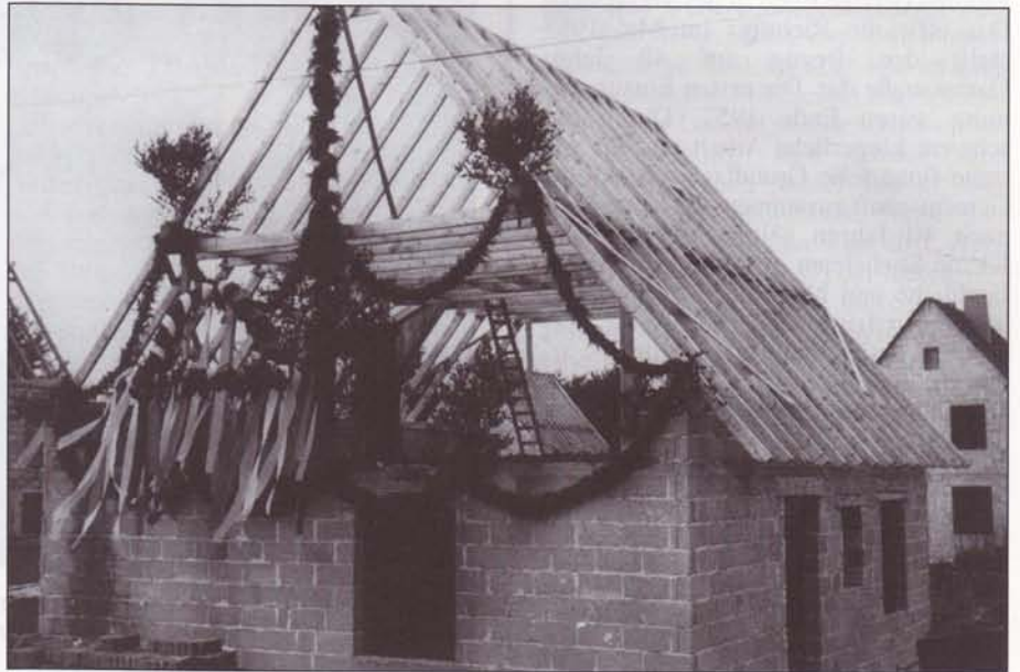
Richtfest an der Gartenstraße in Hamminkeln im Mai 1957. Geschmückt das Wohnhaus im Rohbau von Johannes und Maria Schmitz. Rechts im Hintergrund der Rohbau von Johannes und Agnes Overkamp.
