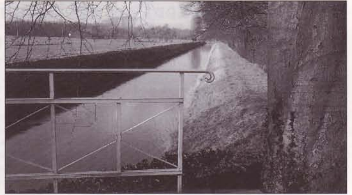
Ein extrem begradigter Verlauf zwischen trapezförmigen Dämmen kennzeichnet diese Strecke der Mittleren Issel bei Hamminkeln.
