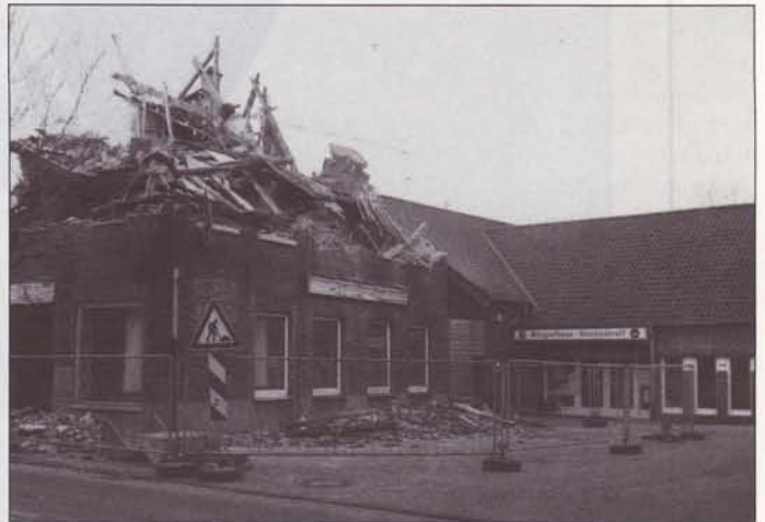
Da kam der Retter mit dem Abbruchhammer aus Wesel –
