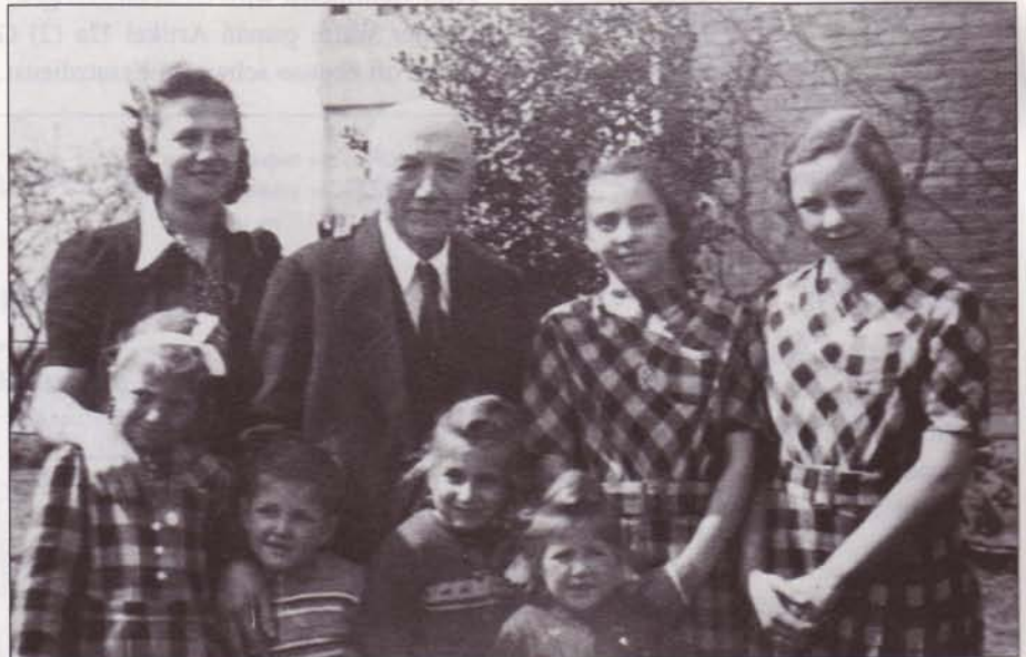
Foto vom 10. April 1948 am Trafo „Hülshorst“ an der Mehrhooger Straße.
