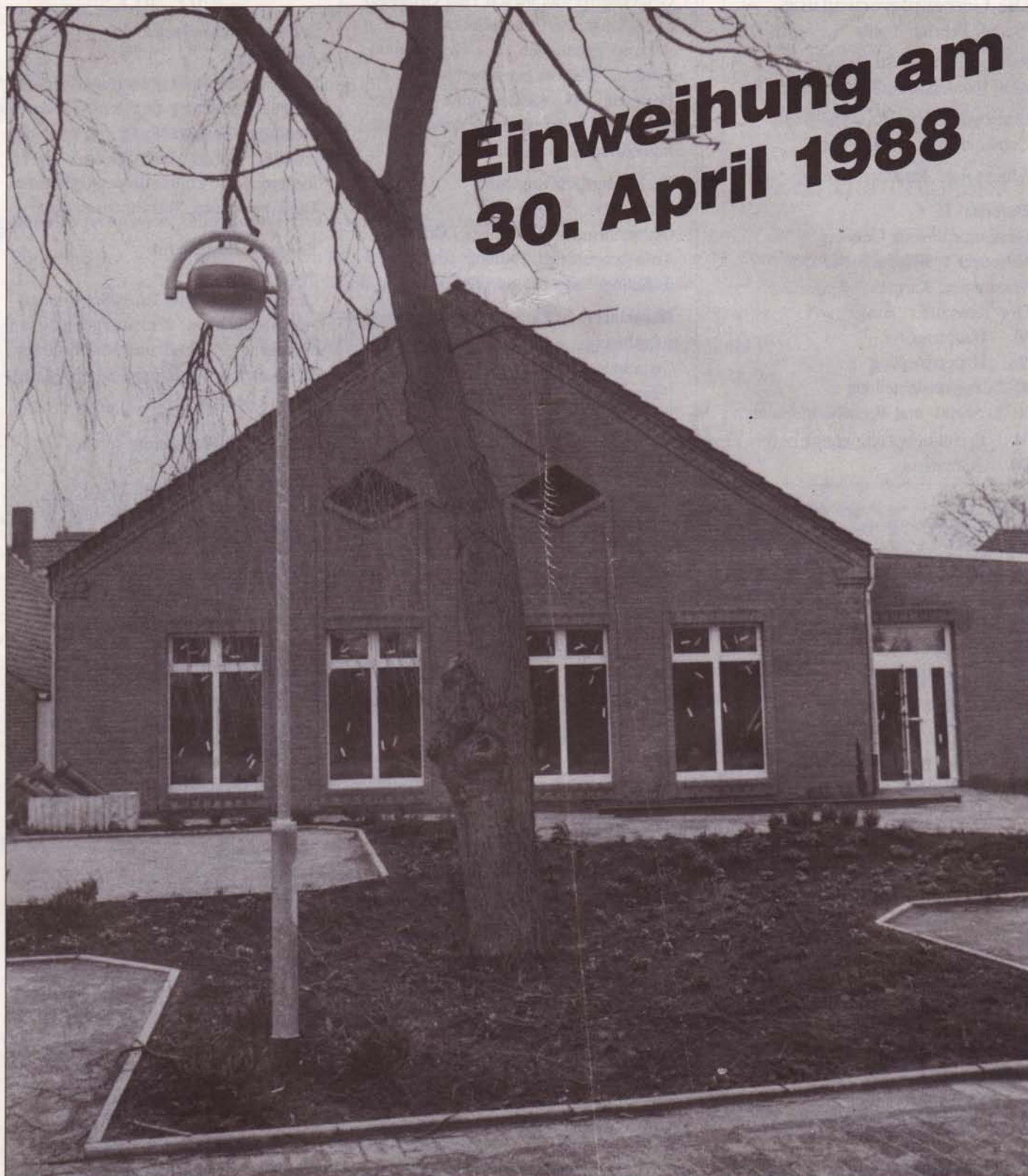
Nordansicht: Bürgerhaus Friedenshalle Hamminkeln
