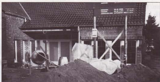
Eingangsbereich Bürgerhaus Friedenshalle, Februar 1988.
