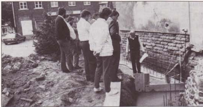
Architekt H. W. Schlebes erläutert den Stand der Renovierungsarbeiten. — 14. 9. 1987 —
