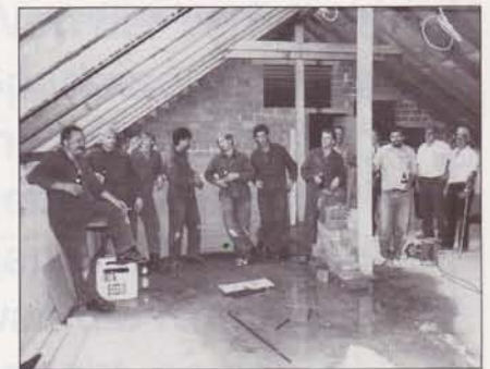
Einsatz Patensoldaten am Bürgerhaus am 17. Juli 1987, rechts im Bild der „gute Geist“ der Baustelle, Heini Joormann.
